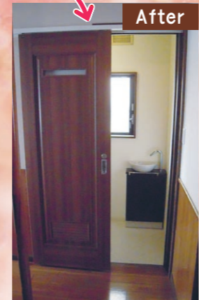
アウトセット扉で引き戸から引き戸に。床の段差もなしに。
