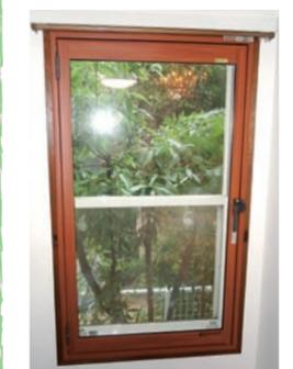
リビングの窓3ヶ所に、内窓を取り付けました。床暖房と合わせて断熱性アップ。
