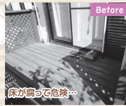
床が腐って危険...
