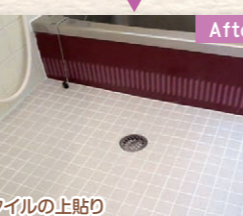
タイルの上貼り
