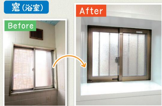
浴室の窓、断熱効果の高いペアガラス（複層ガラス）に交換しました。お風呂の中で暖められた空気を逃さず、浴室外の空気をシャットアウトすることができます。
