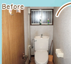
Before タンクをなくしてスッキリさせたい。ドアが内開きの開き戸でした。
