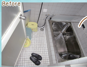
Before 床も壁もタイル貼りの昔ながらのつくりで、寒い。入口は開き戸で段差がある。
