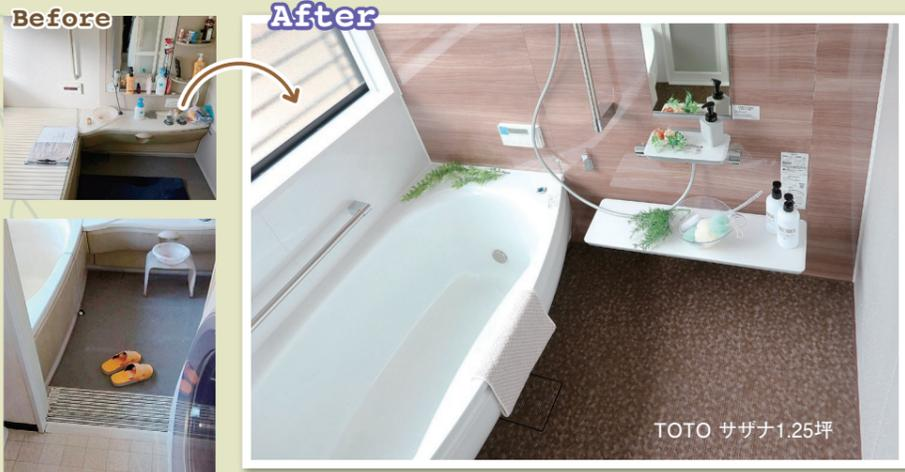
浴室入口にある排水溝が大きく、掃除が大変。2階に設置されたハウスメーカーの浴室でしたので、配管などの構造上、設置可能なシステムバスを提案し、リフォームを行いました。
