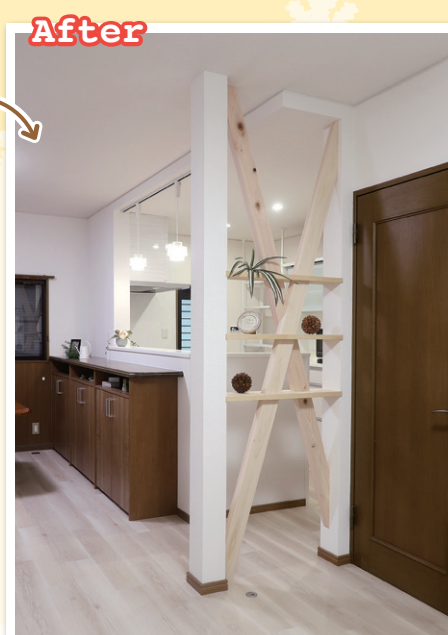
After 撤去出来ない柱は、自然な木目がきれいな 筋交いと棚を設置することで、インテリアと して活用しています。
